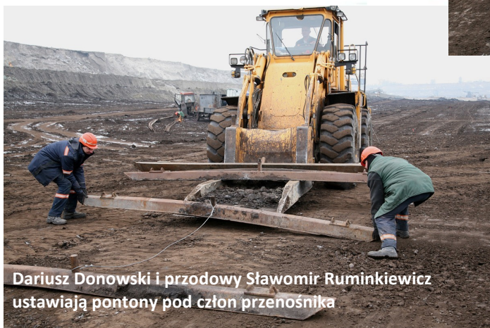
Przenośnik W-10 jest wydłużany od strony stacji zwrotnej
