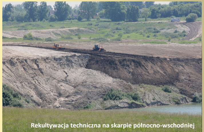
Rekultywacja techniczna na skarpie północno-wschodniej
