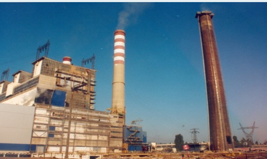
W tym miejscu powstanie nowy blok 464 MW.
