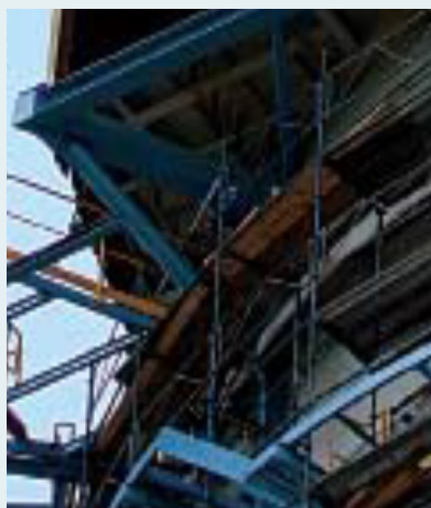
Montaż instalacji odsiarczania
