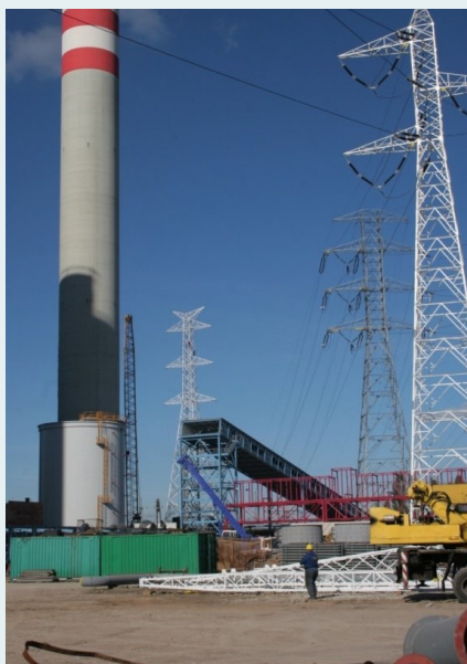
Montaż szybu nawęglania
